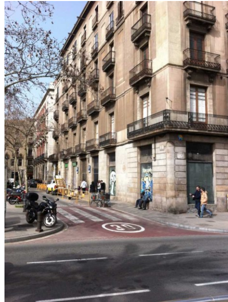
FOTO 2. Vista general de la cantonada amb la plaça del Duc de Medinaceli
