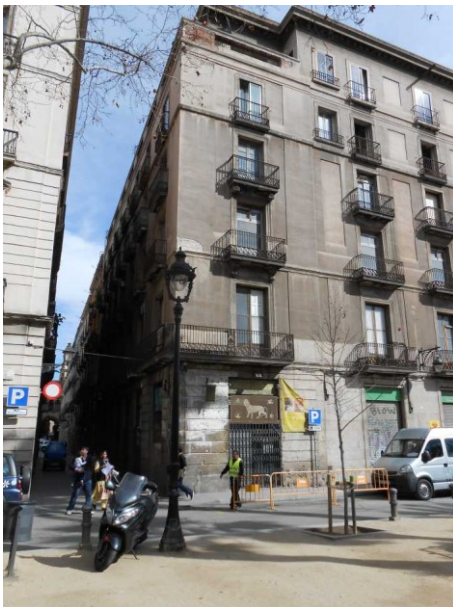
FOTO 3. Vista general de la cantonada amb el carrer de la Mercè
