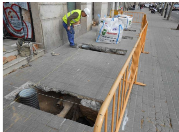
FOTO 4. Vista general de les sabates de la façana del passeig de Colom
