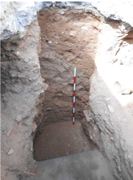
FOTO 7. Detall de l'estratigrafia de les sabates de la façana de la plaça del Duc de Medinaceli
